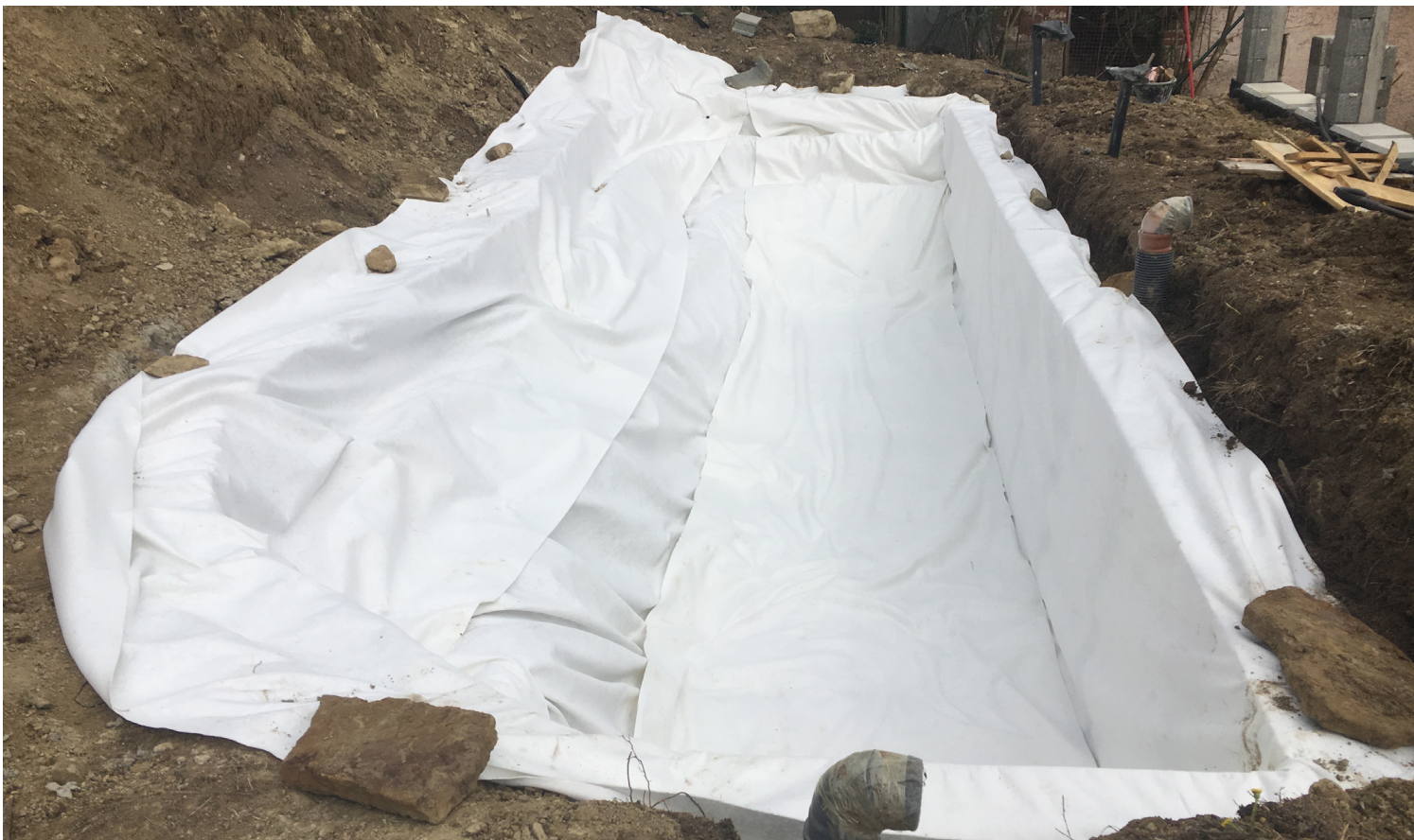
výstavba kúpacieho jazierka v náročnom svahovitom teréne (1/2)
